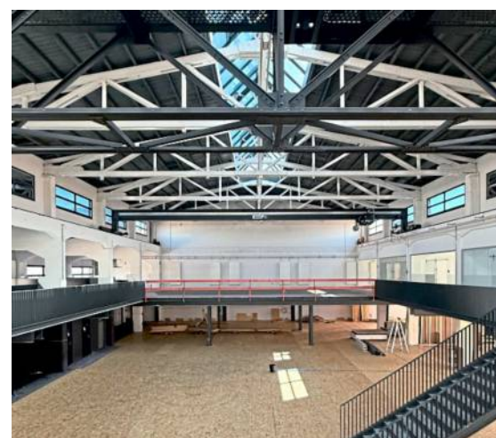
Umbau des neuen Vertriebsstandorts von AssenheimerMulfinger in Ludwigsburg. Foto: privat
